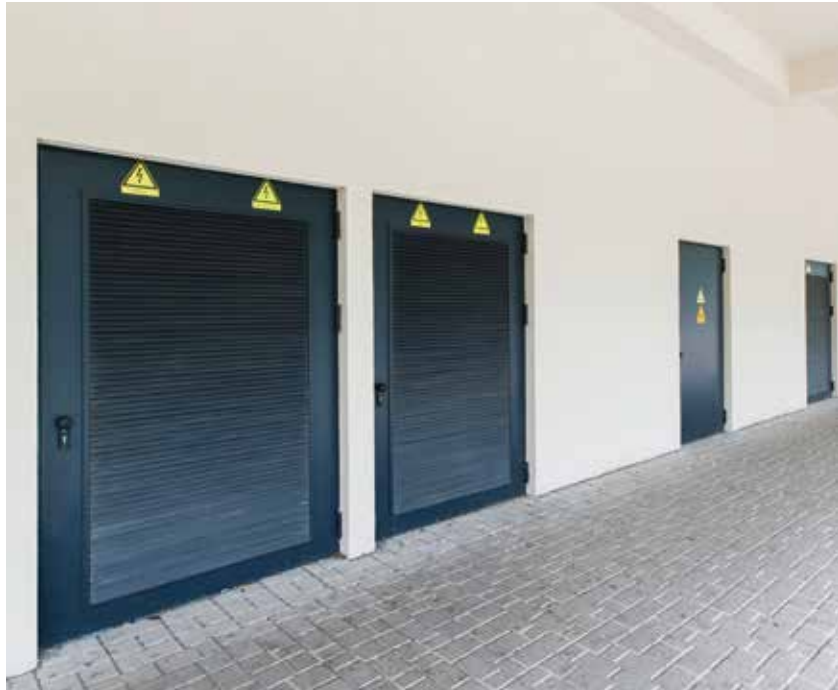
Mehrzwecktür mit Trafogitter
